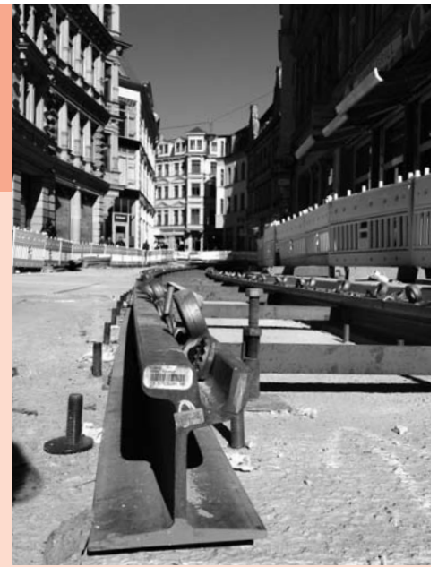
Mit den Bauarbeiten in der Großen Ulrichstraße und dem Ausbau des Streckennetzes Torstraße wurden im Jahr 2013 die ersten Meilensteine des Projektes STADTBAHN Halle umgesetzt.
