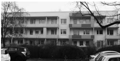
Von fünf auf drei Etagen – gelungener Teilrückbau im Quedlinburger Weg
