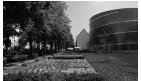
Rechts im Bild: Erschließungsbauwerk der Großgarage Süd
