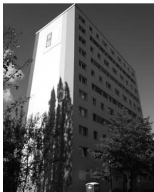
Sanierter 11-Geschosser in der Voßstraße 9
