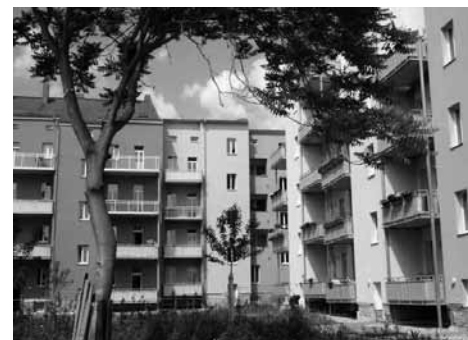
Innenhofansicht Dzondistraße 5, 6, Forsterstraße 44–46
