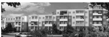
Grundinstandsetzung und energetische Sanierung am Göttinger Bogen 13–67
