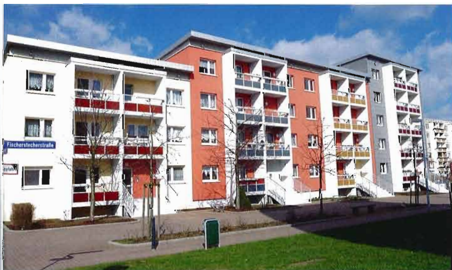
Gelungene Aufwertung genossenschaftlicher Wohnungen in Plattenbauweise in Halle.
